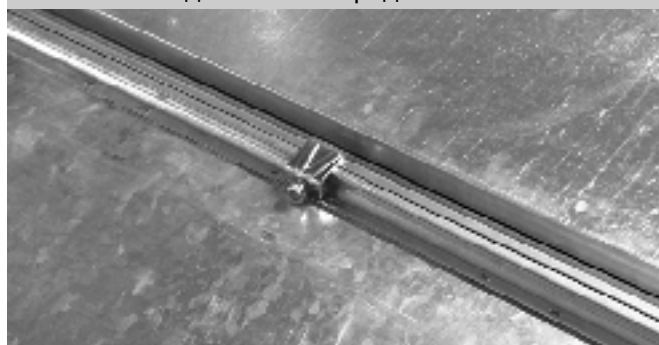
Рис. 13 – соединение посередине скобой
